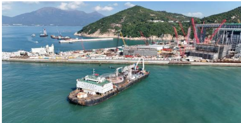
採用水力噴注方式鋪設海底電纜
