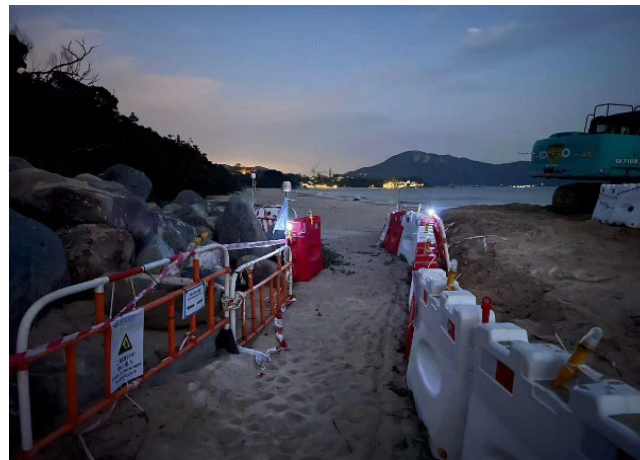
妥善圍封工地範圍，提供足夠照明
