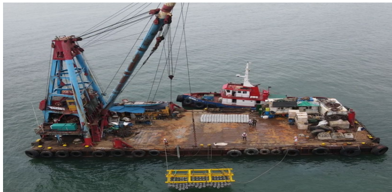
在近岸段為電纜加裝保護設施
